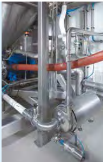
Druckerhöhungspumpe für die CIP-Reinigung
