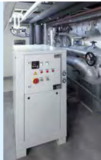
Versorgungsmodul zum Heizen und Kühlen des Prozess- und des Schmelzbehälters
